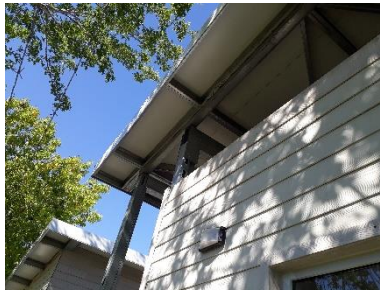
Bocas de Iluminación Exterior
