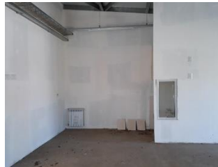
Salas (Colocación Piso Vinílico Según Pliego)
