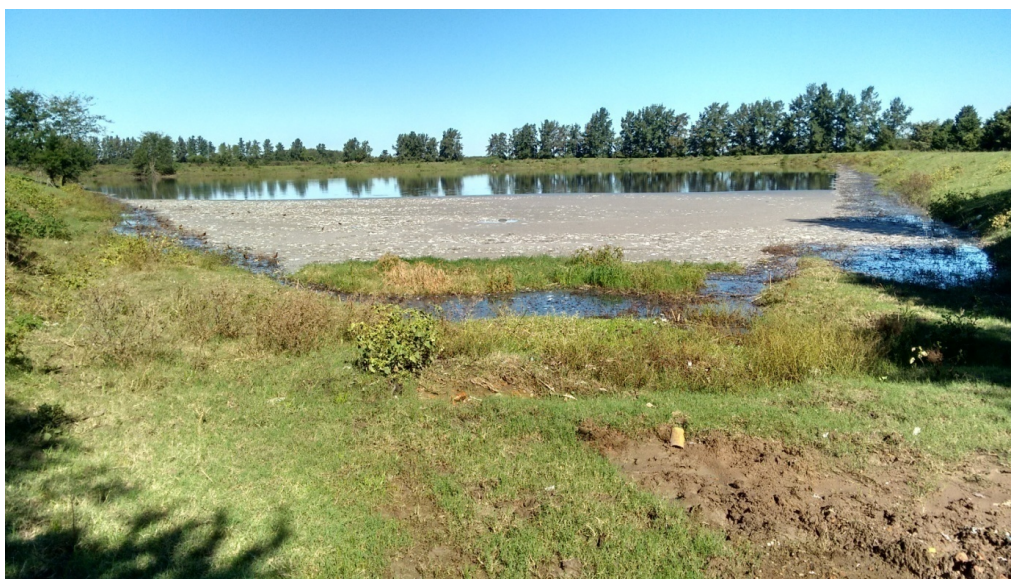
Imagen 8. Sólidos en suspensión, sector de descarga de camiones atmosféricos.
